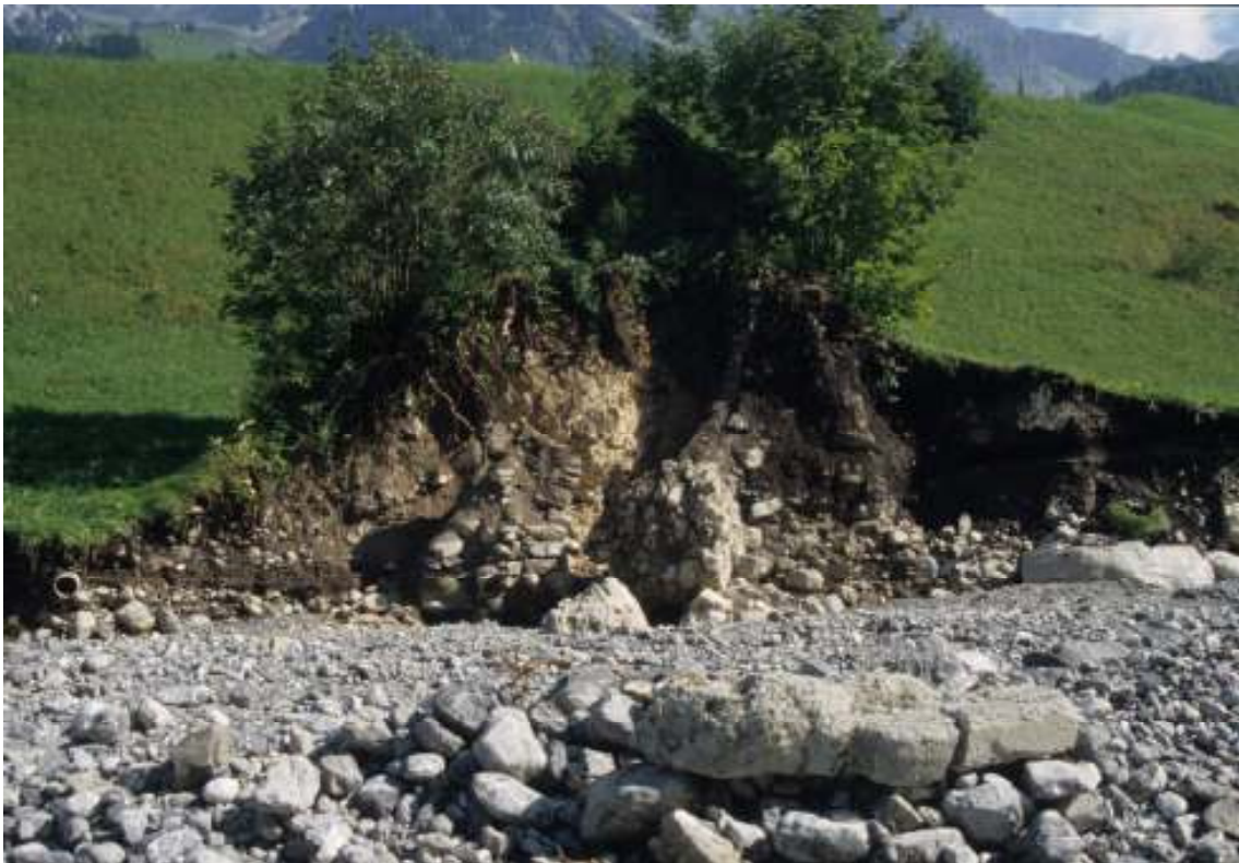
Abb. 3: Ruine des Hochofens mit aufgerissener Front (Foto: J. Obrecht, August 2005)
