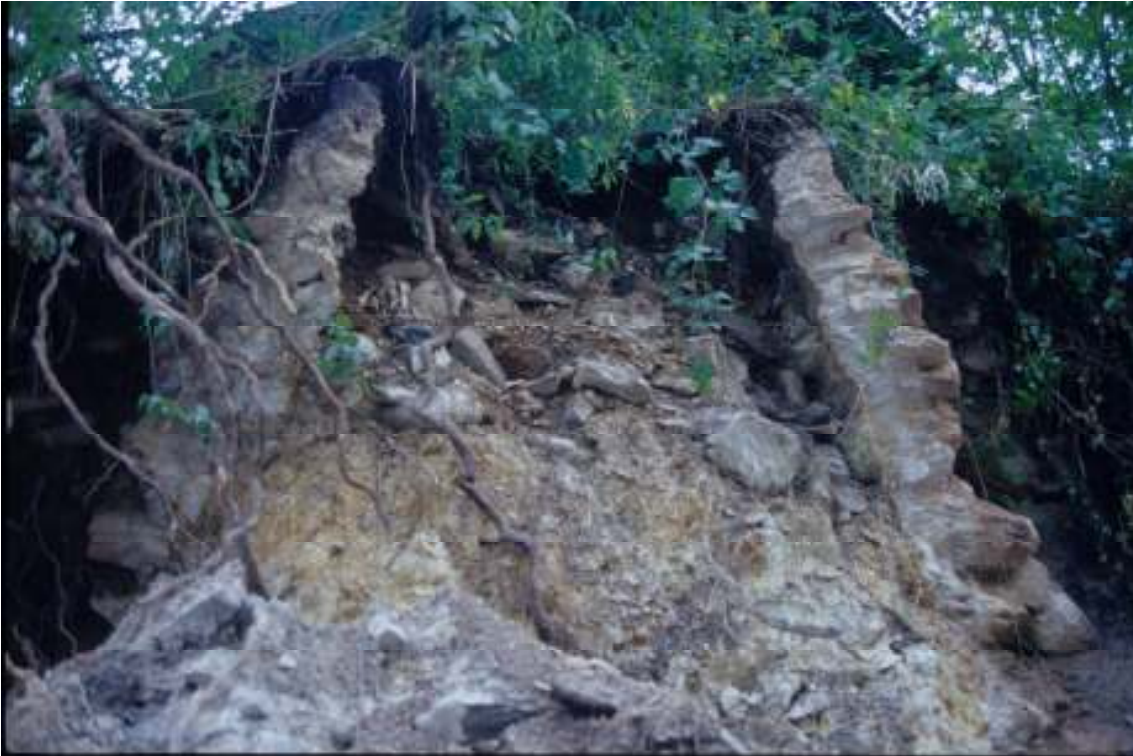
Abb. 4: Aufgerissener Schachtkopf des Hochofens (Foto: J. Obrecht, August 2005)
